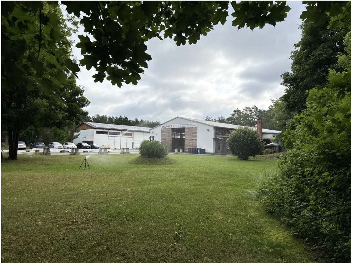
Abbildung 7: Blick auf die östlichen Produktionshallen mit davorliegendem Scherrasen. Standort nahe der Gehölzbereiche entlang der südlichen Grundstücksgrenze etwa mittig.
