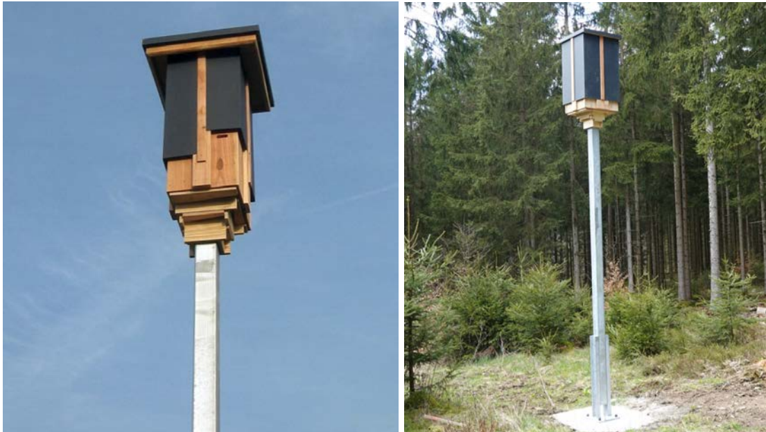
Abbildung 23: Fledermausturm aus Mehrschichtplatten und unbehandeltem Holz.
