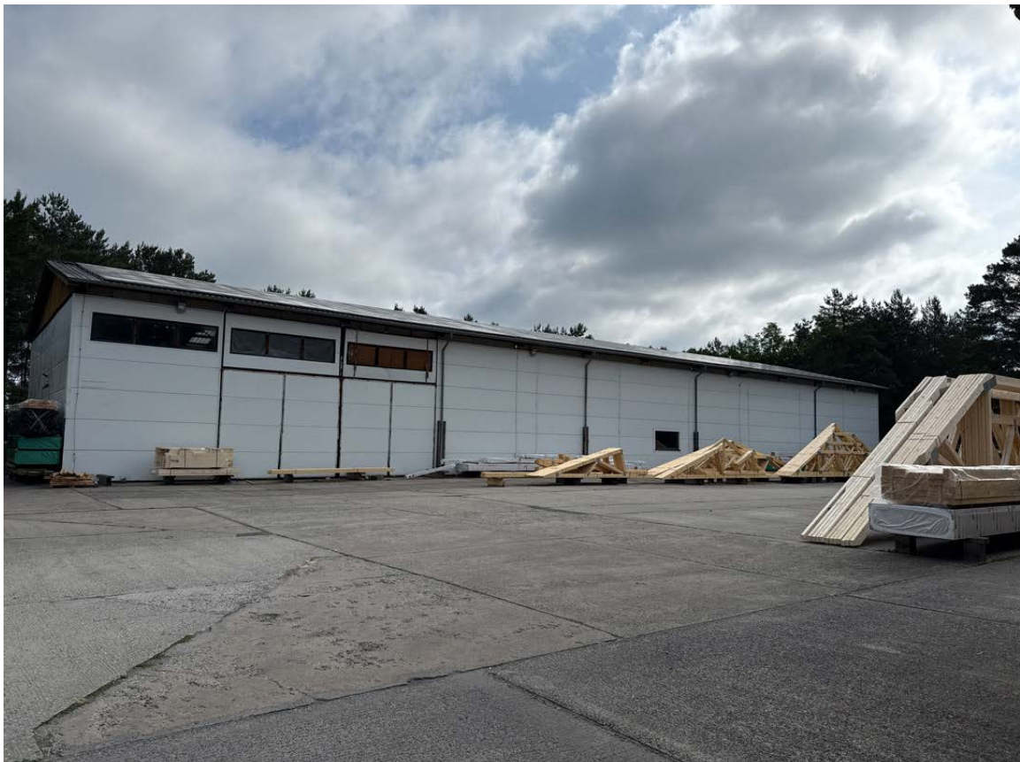
Abbildung 8: Produktionshalle 1 im Osten des Grundstücks.
