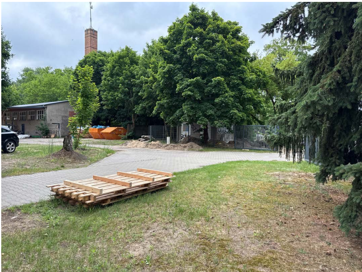
Abbildung 6: Blick auf Schuppengebäude am südlichen Grundstücksrand sowie die dortigen Freiflächen. Standort westlich der Werkhalle nahe der Zufahrt Prendener Straße.
